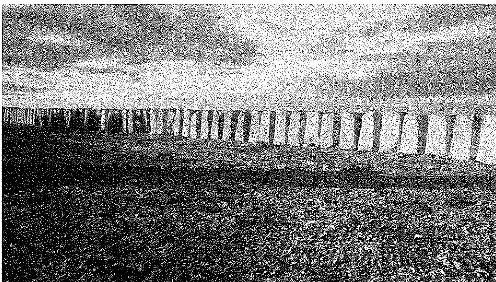
Foto 8 del 22.01.2014 – La protezione provvisoria in "antifer" del secondo braccio del molo di sopraflutto
