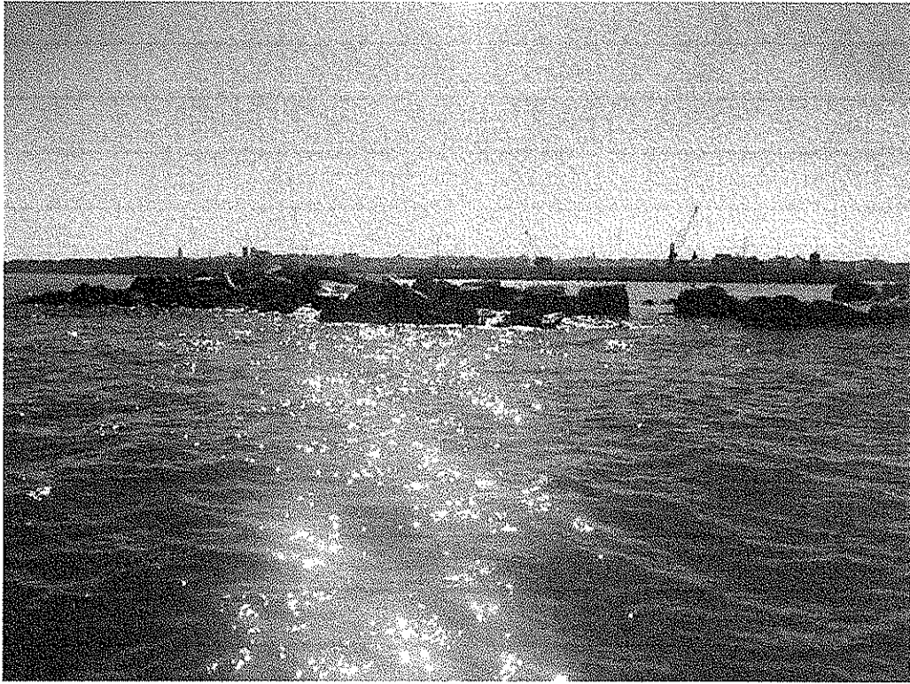
Foto 13 del 27.10.2017 – La testata provvisoria del secondo braccio del molo di sopraflutto
