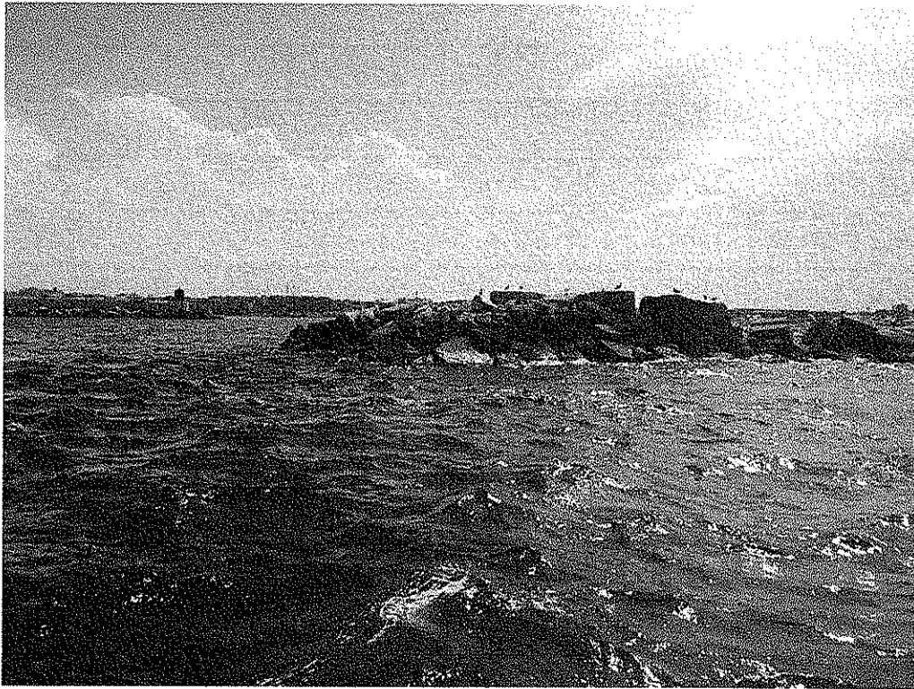
Foto 11 del 28.07.2016 – La testata provvisoria del secondo braccio del molo di sopraflutto
