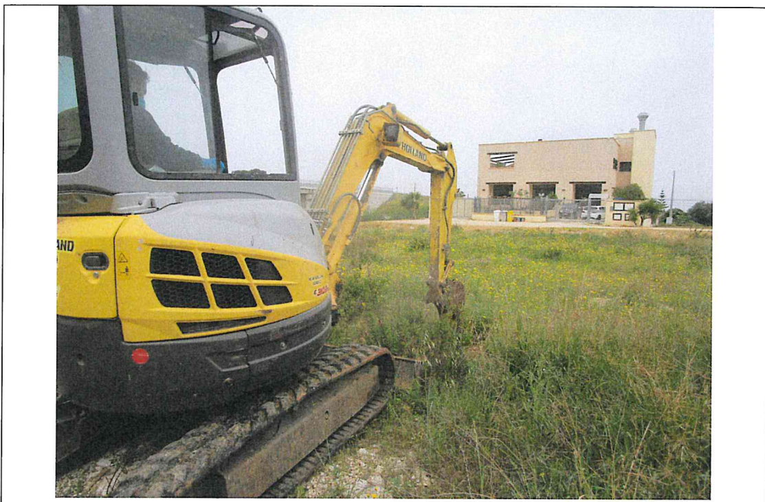
Esecuzione pozzetto geognostico e prelievo dei campioni Ca9 alle diverse profondità
