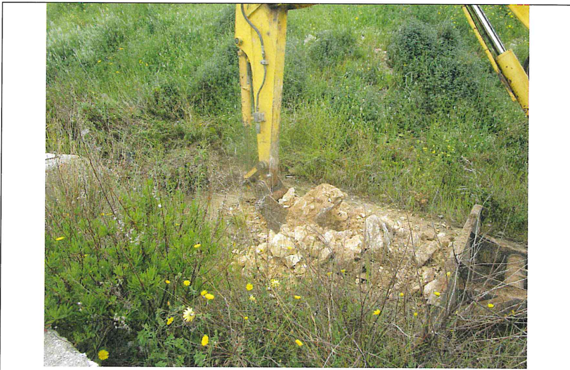
Esecuzione pozzetto geognostico e prelievo dei campioni Ca11 alle diverse profondità
