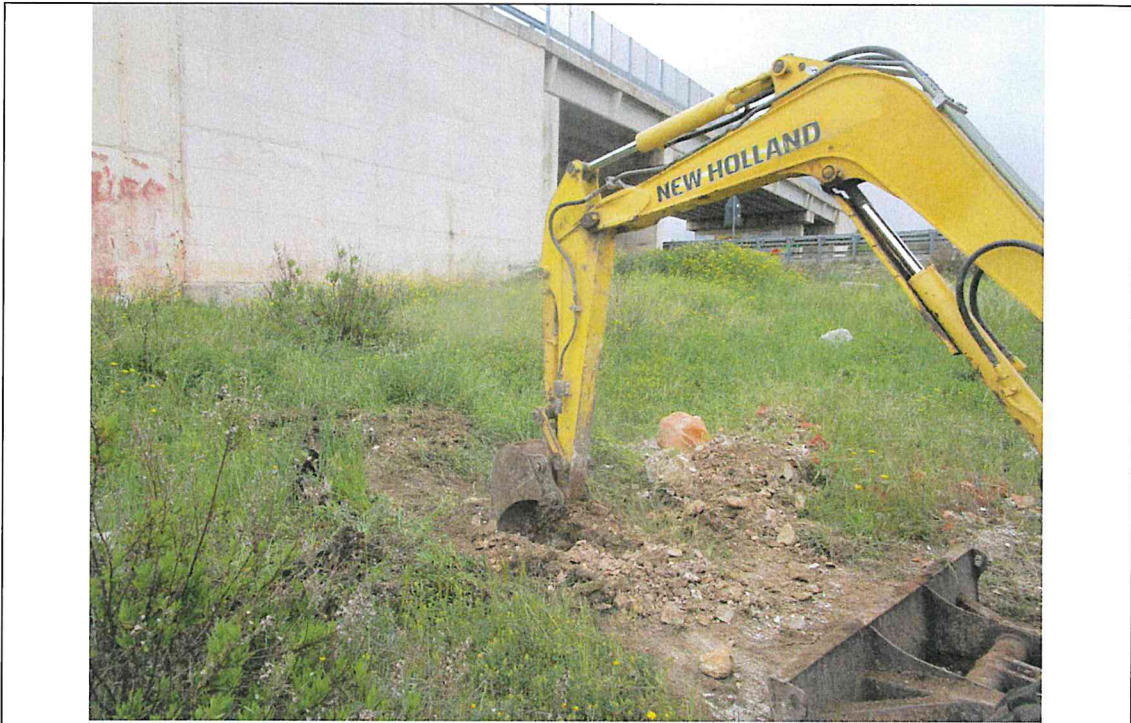
Esecuzione pozzetto geognostico e prelievo dei campioni Ca10 alle diverse profondità
