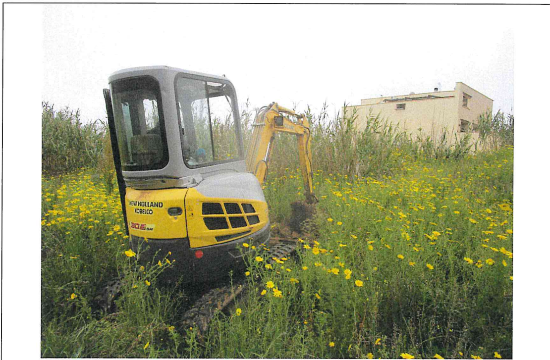
Esecuzione pozzetto geognostico e prelievo dei campioni Ca8 alle diverse profondità
