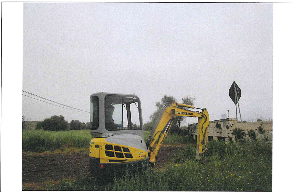
Esecuzione pozzetto geognostico e prelievo dei campioni Ca2 alle diverse profondità
