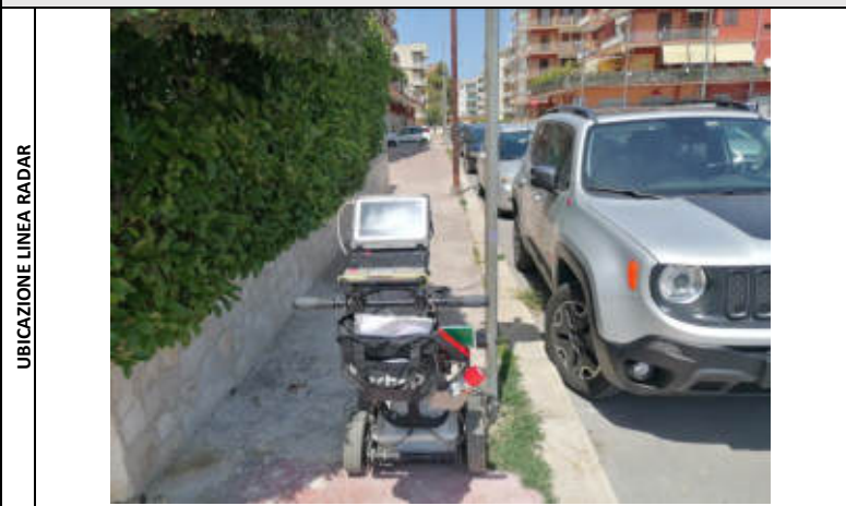
FOTO GEORADAR – C02
