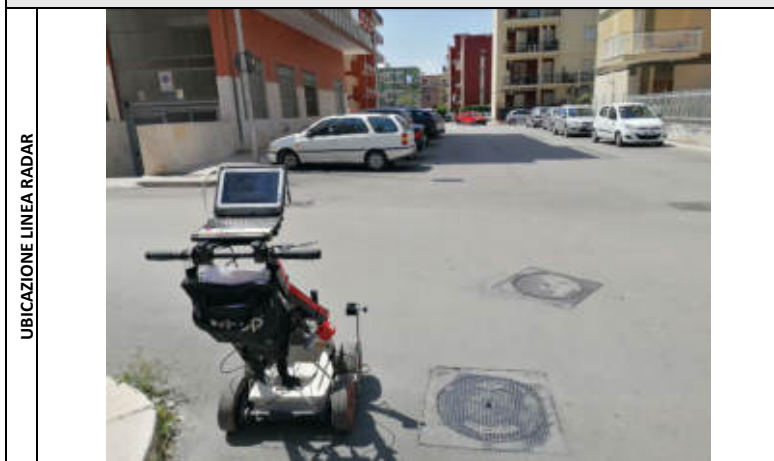
FOTO GEORADAR – C06
