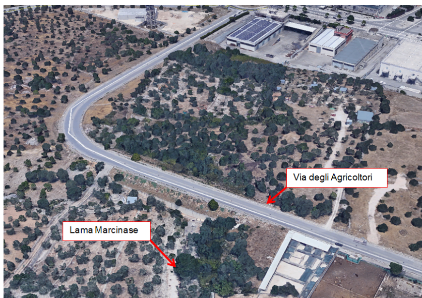
Figura 2.1 - Criticità riscontrate lungo la lama Marcinase
