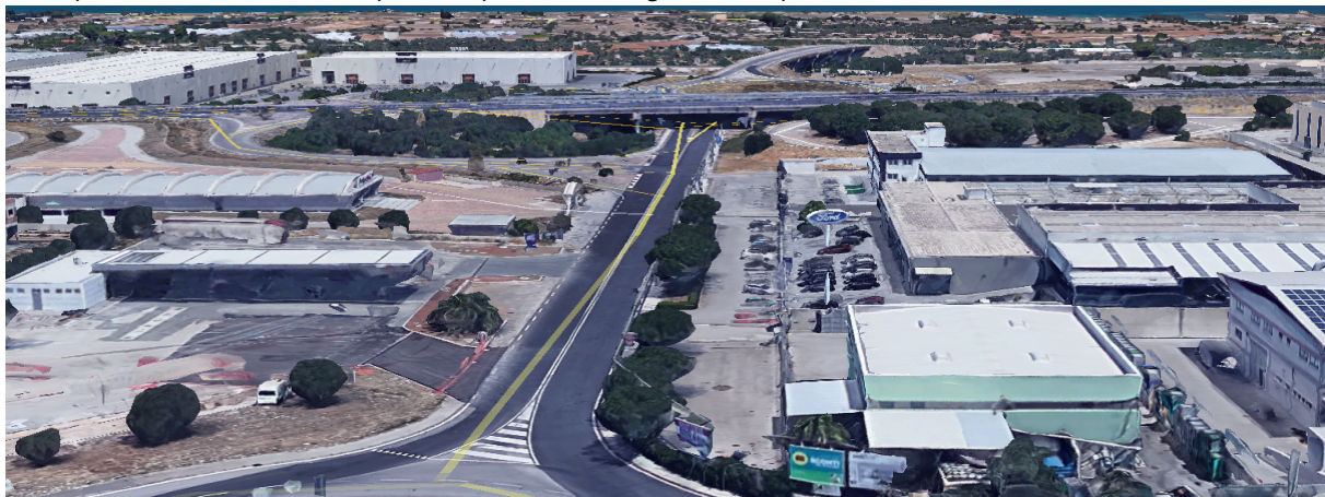
Figura 2.2 – La lama lungo “Via dei Lavoratori”
