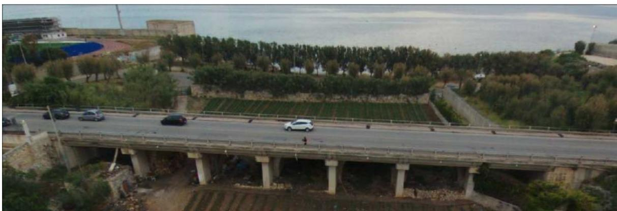
**Figura 5.3-3:** Tratto Lama Cupa - è stato realizzato l'allargamento dell'impalcato stradale del ponte con struttura in cemento armato – vista da monte
