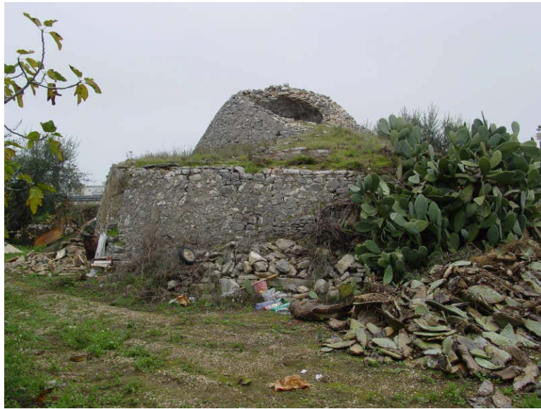
Figura 3.2.1-6: Complesso rurale Loc. Belvedere
