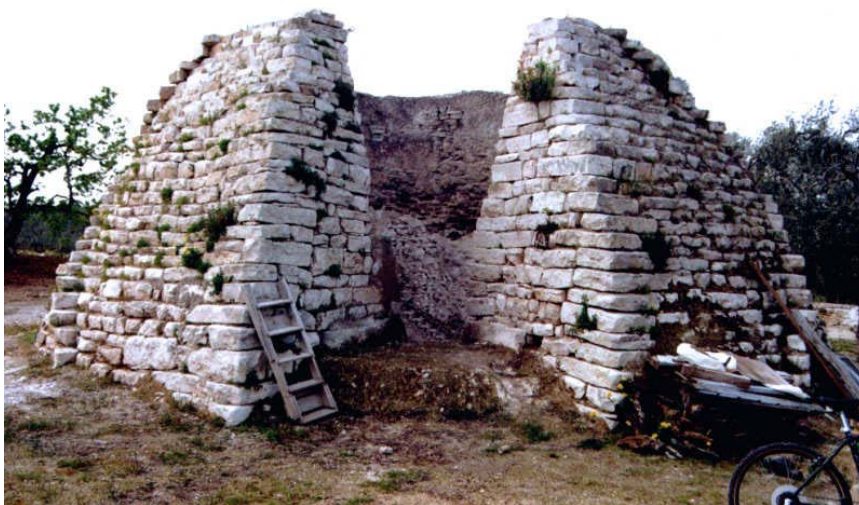
Figura 3.2.1-8: Fornace per la cottura della pietra (Calcara) - Loc. Torre Falcone
