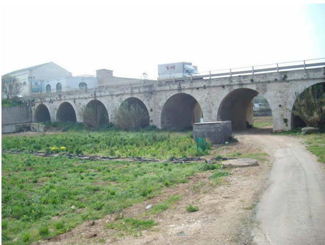
Figura 3.2.1-12: Ponte in pietra - Loc. 1° cala
