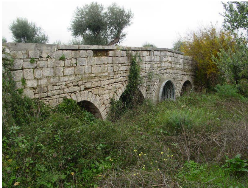
Figura 3.2.1-7: Ponte in pietra - Loc. Coppe
