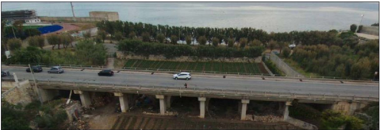
Figura 4.3-3: Tratto Lama Cupa - è stato realizzato l'allargamento dell'impalcato stradale del ponte con struttura in cemento armato – vista da monte
