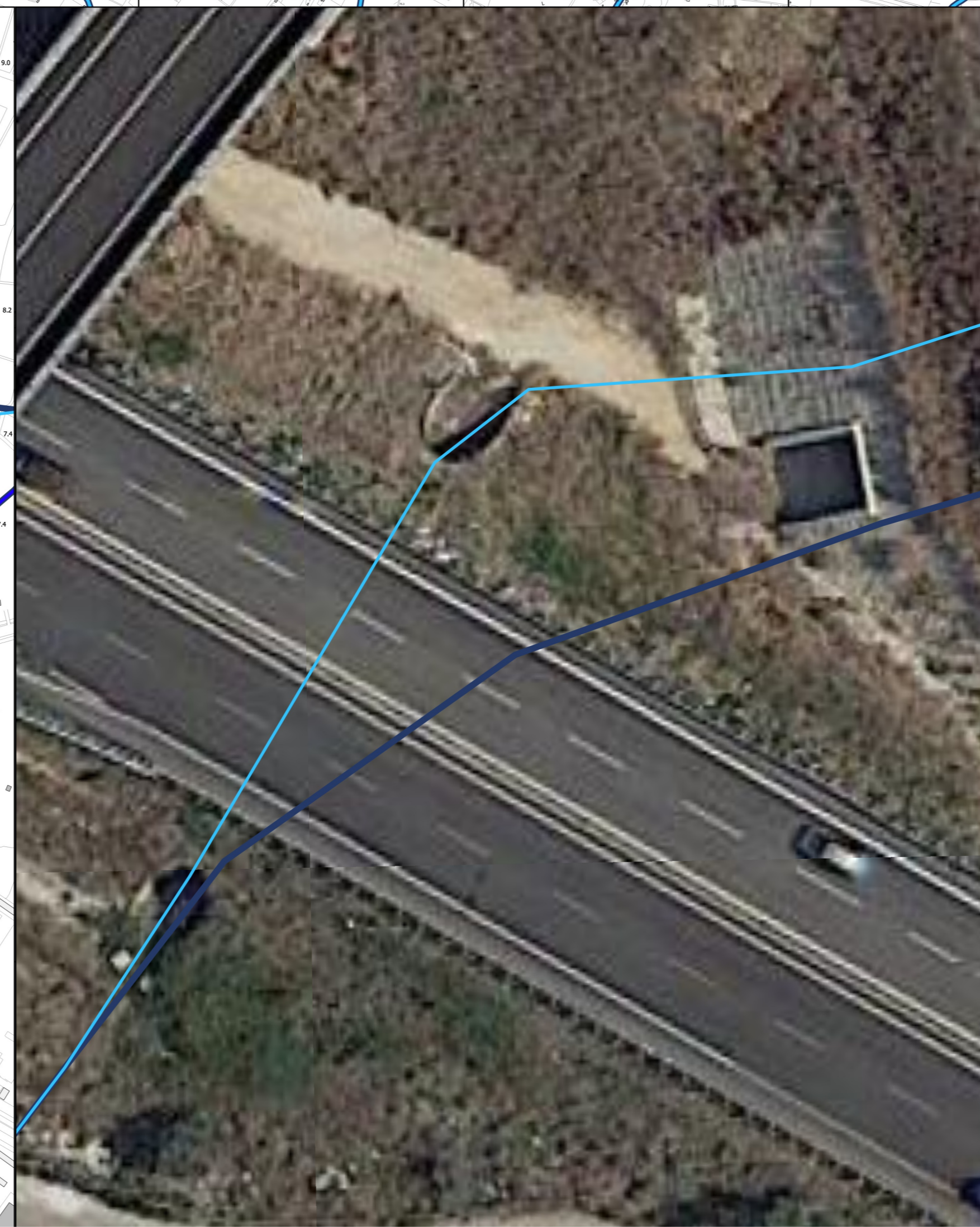
Presenza di opere di canalizzazione del percorso
