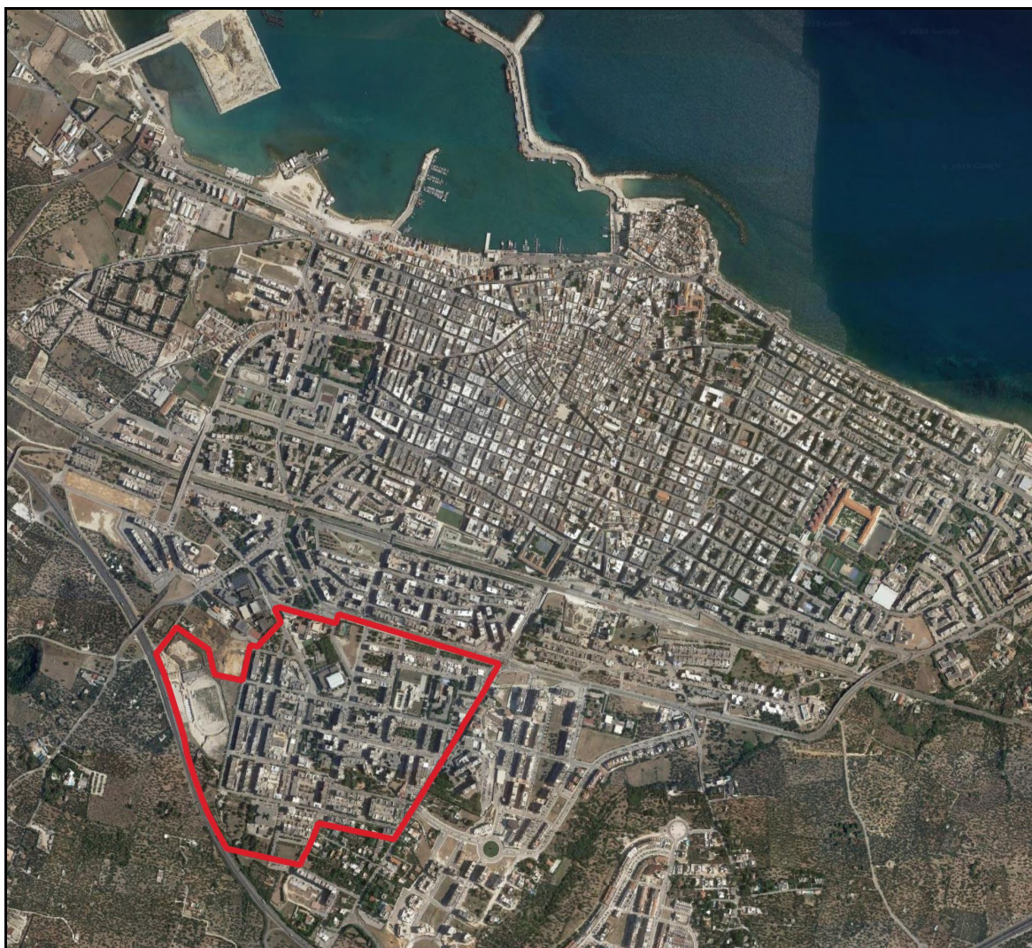
Figura 1 Individuazione di una porzione di territorio omogenea nell'intorno della sottozona B4 del P.R.G.C.
