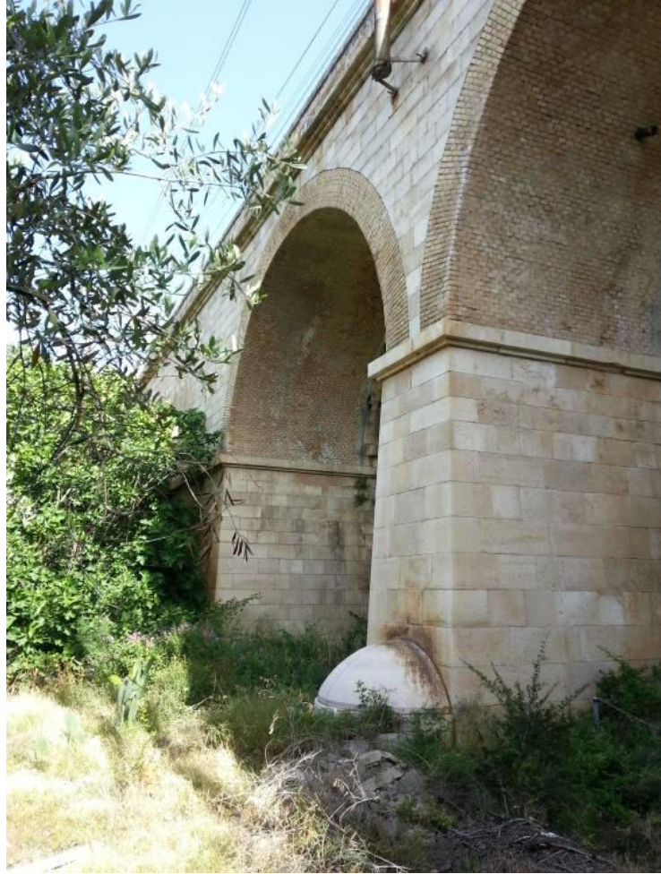
Figura 20: Ponte C7 - Particolare
