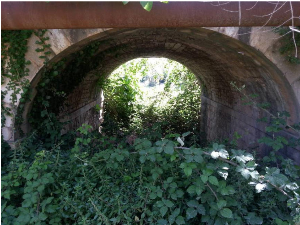
Figura 18: Singola luce del Ponte C6
