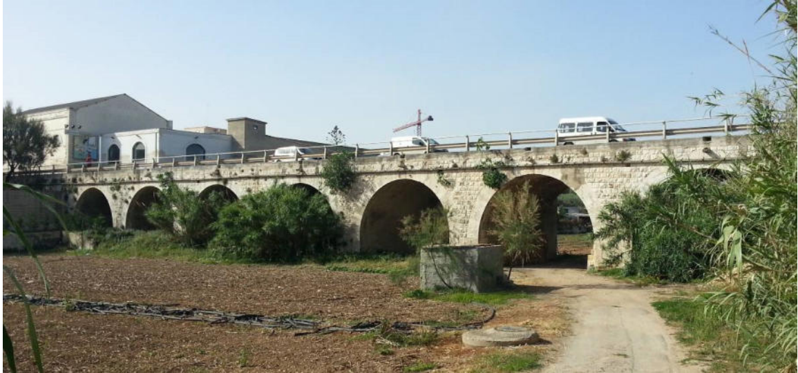
Figura 22: Ponte C9 a sette luci
