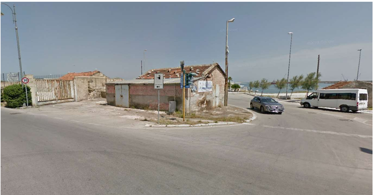
9 Suppigna da demolire
