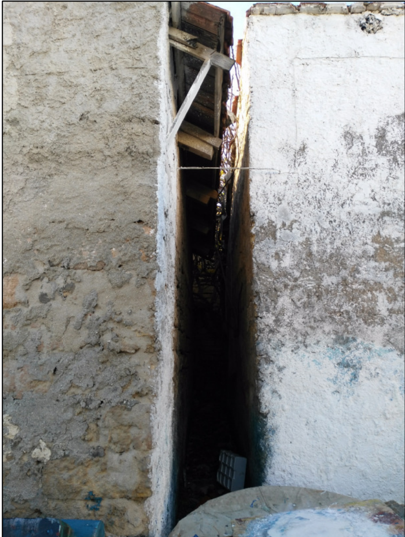
Dettaglio prospetto Nord Edifici n. 02-03
