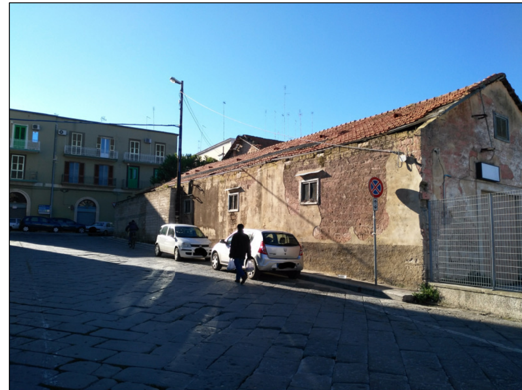
Prospetto Est - edificio n. 27
