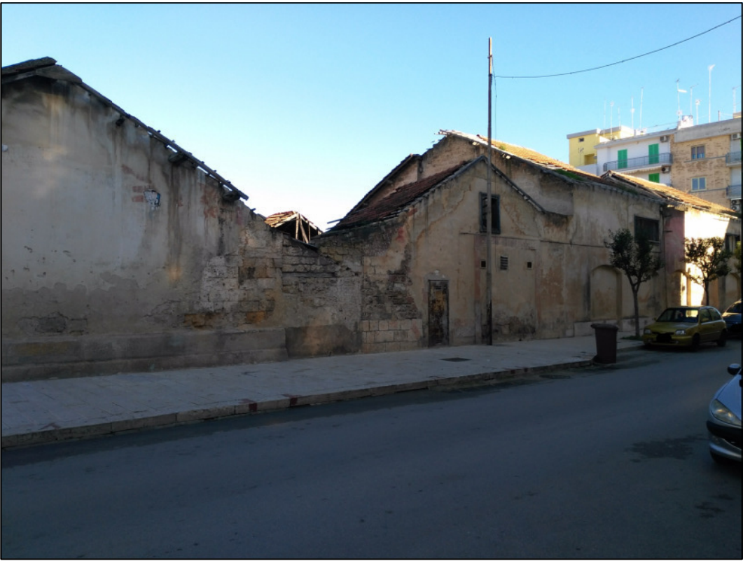
Prospetto Sud - edifici n. 25-26
