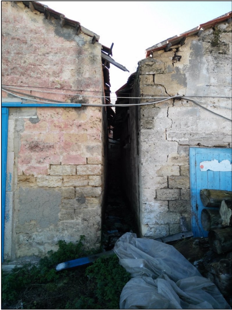
Dettaglio prospetto Nord Edifici n. 06-07
