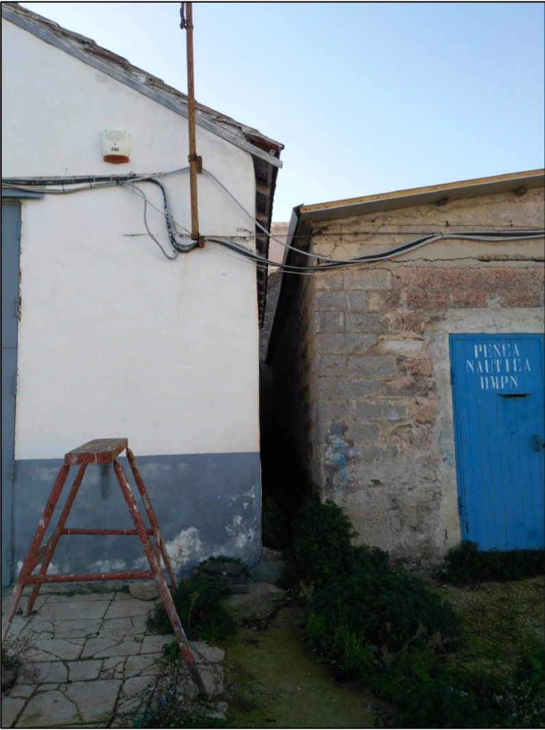
Dettaglio prospetto Nord Edifici n. 08-09
