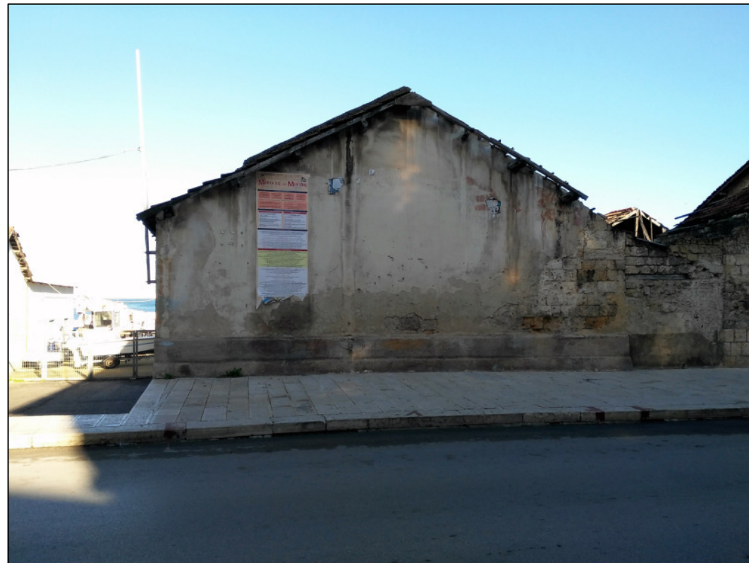
Prospetto Sud - Edifici n. 25-26
