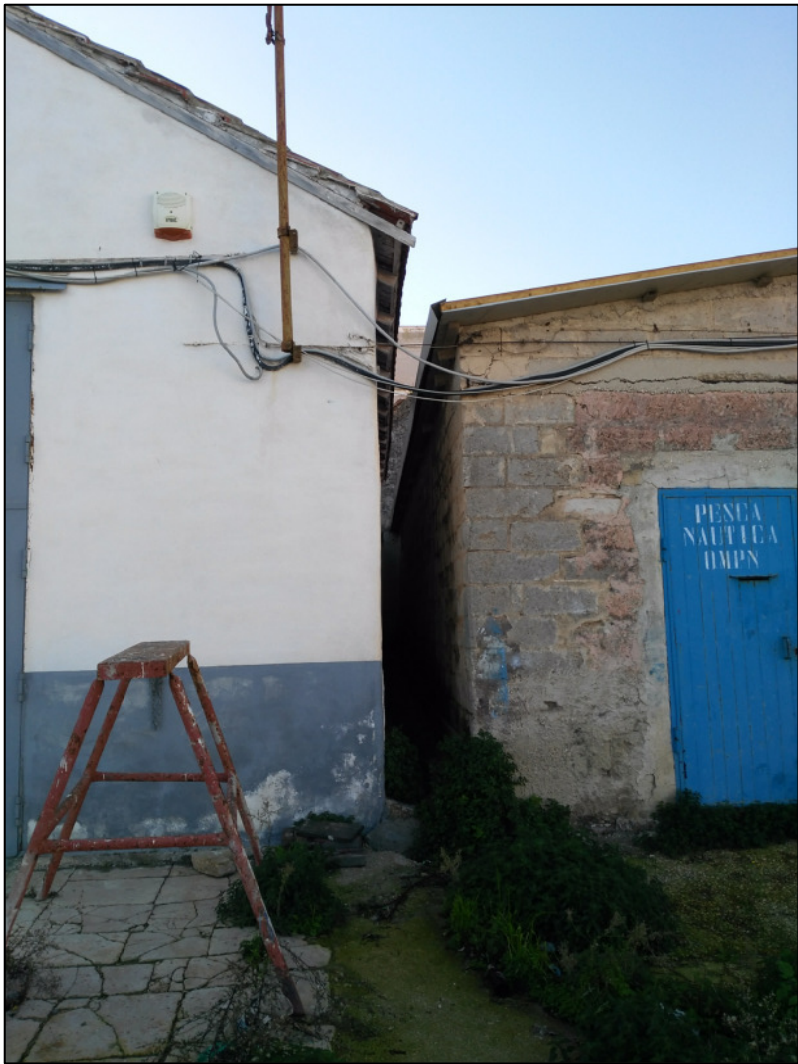
Dettaglio prospetto Nord Edifici n. 08-09
