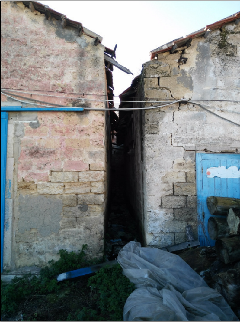
Dettaglio prospetto Nord Edifici n. 06-07
