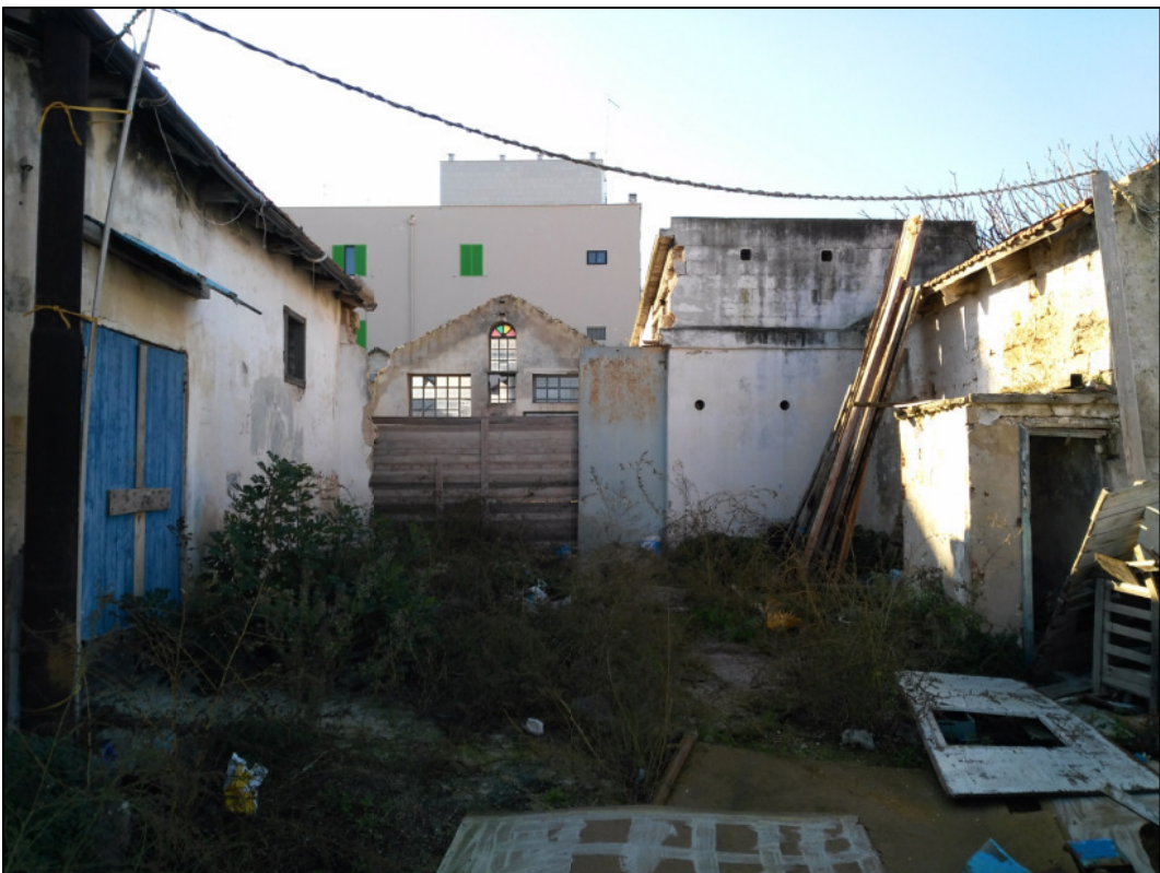
Muro perimetrale tra Edifici n. 03 e n. 05
