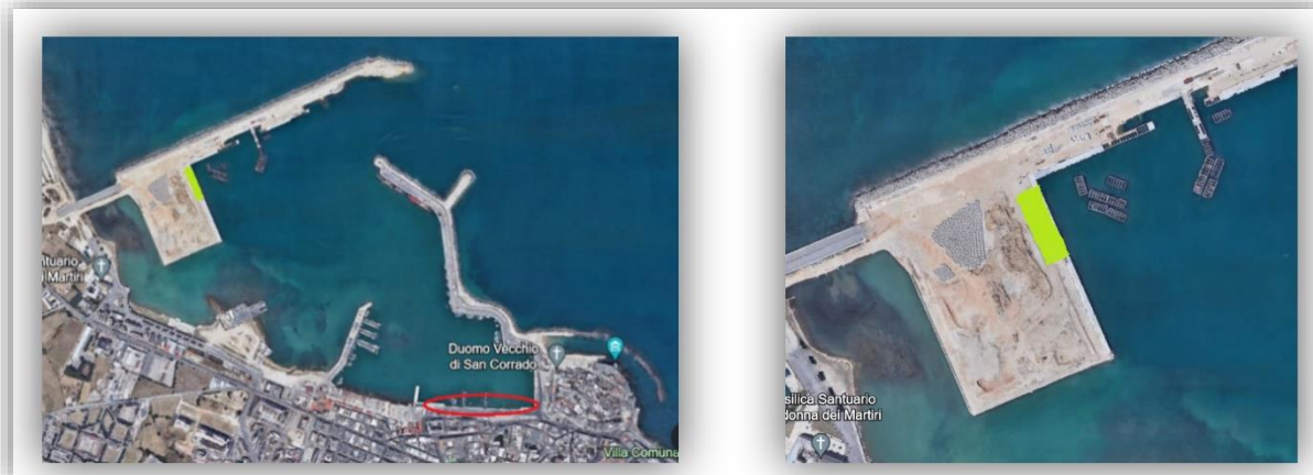
Figura 8 - area di cantiere denominata "zero"
